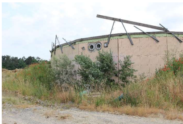
Aufgelassene Baustelle mit Sukzession © Klärle GmbH, 19.6.2023
